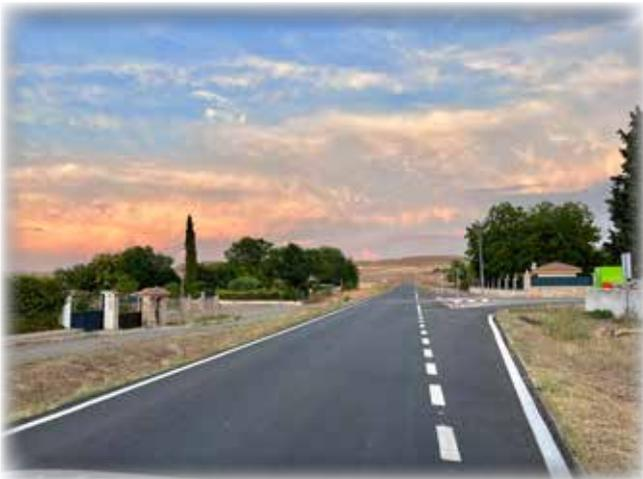
Recordemos, además, que en la carretera GU-282, vía que nos une con la Comunidad de Madrid, se mejoró el firme de su primer tramo, se pintó toda la señalización horizontal, reforzando la vertical en sus puntos más peligrosos y se instalaron new jersey de hormigón que, junto con la protección de vehículos, actúa como contención de áridos en la zona de la salida del puente sobre el río
