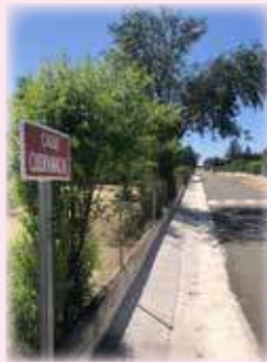
Pavimentación de la calle Cuernavacas (170 m)
