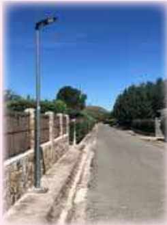
Actualización de toda la red de alumbrado común, instalando equipos led
